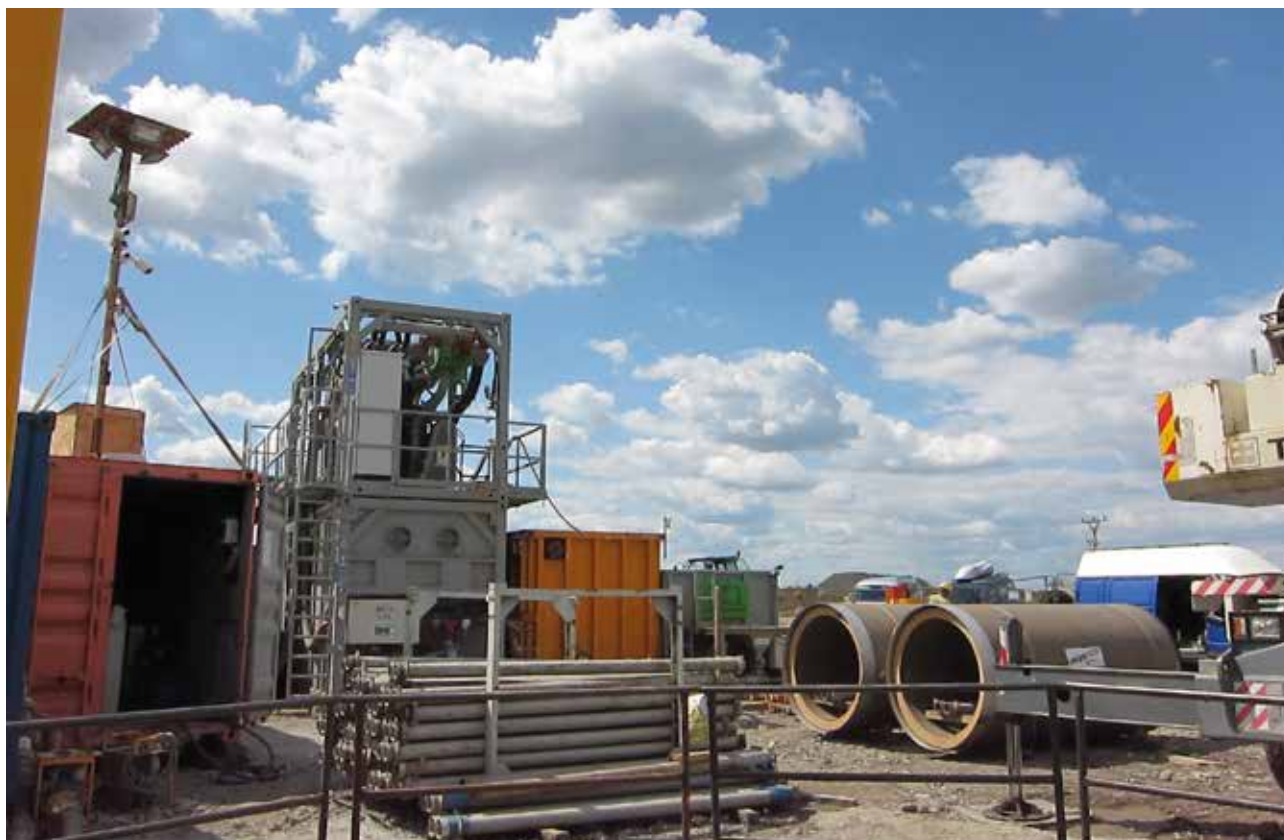
Obr. 3 Protlačovací trouby POLYCRETE DN 1200, vnější profil 1485 mm, plovoucí spoj
