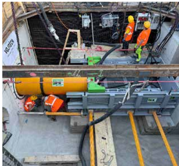
Obr. 3 – Zahájení ražby 1 úseku (foto Subterra)
