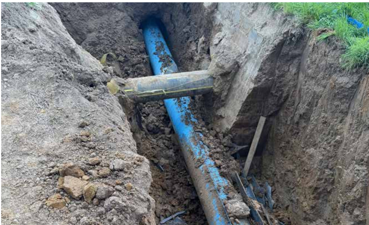
Obrázek 6: Křížení plynu s berstliningem (zdroj: fotoarchiv OHLA ŽS, a.s.)
