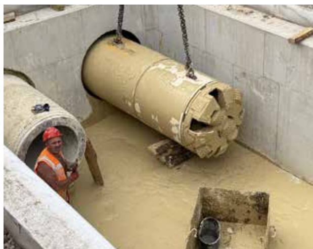
Obr. 5 – prorážka 2 úseku chráničky (foto Subterra)
