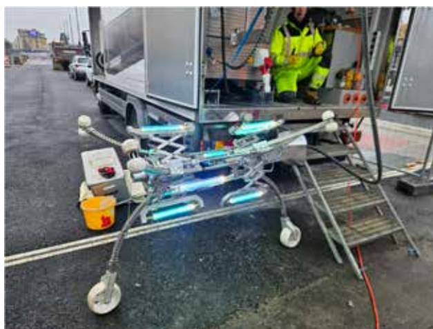
Obr. 4 UV lampový řetěz před zavedením do rukávce. Vytvrzování probíhalo soustavou šesti lamp o výkonu 4 000 W. Foto: archiv TRASKO BVT.
