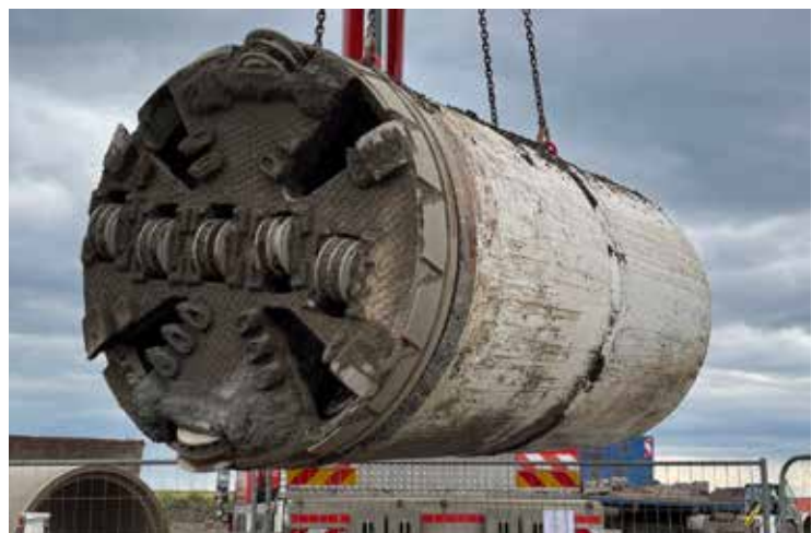
Obr. 4 – Proražení stroje AVN1200 TC do cílové jámy a jeho vytažení
