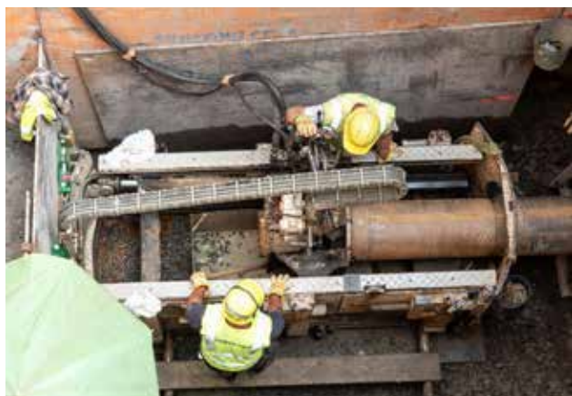
Obr. 1: Zařízení Bohrtec BM400 při rozšiřování vrtu detail ocelové pažnice
