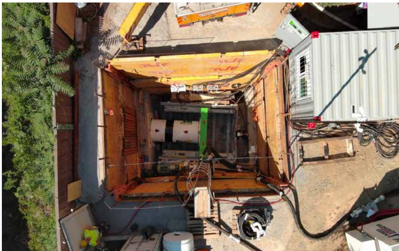
4/ Pohled do startovací šachty ŠA2
