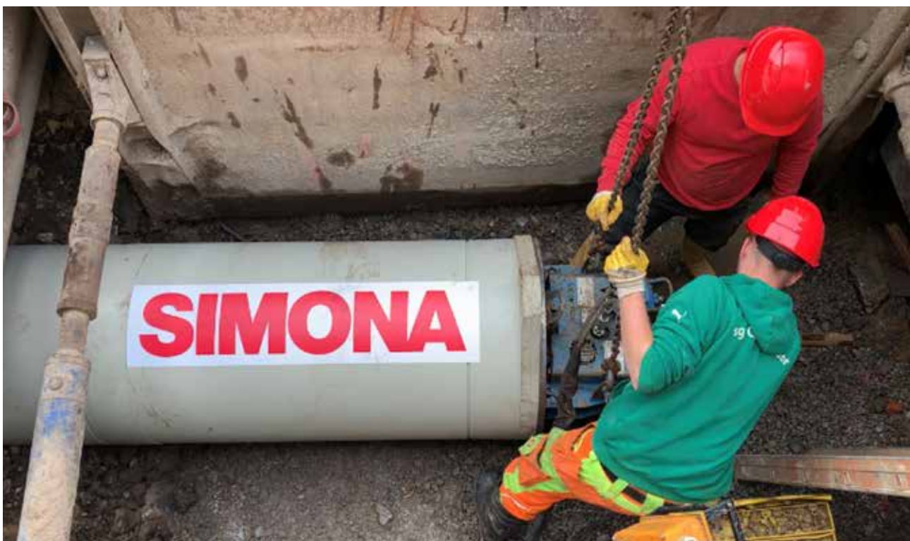
Obr.: Pilotní protlačování (PTM) s PP protlačovacími trubkami ze startovacích šachet DN 2000.
