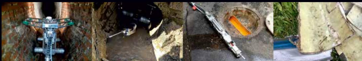
Ultravysokotlaký vodní tryskový robot Bruno (profil vejec 933/1400)
