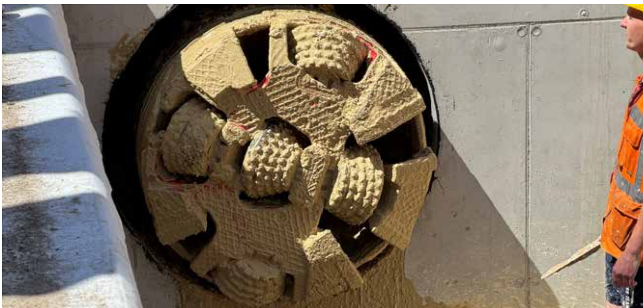
Obr. 4 – prorážka 1.úseku (foto Subterra)
