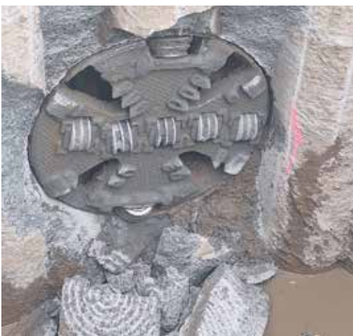
Obr. 4 – Proražení stroje AVN1200 TC do cílové jámy a jeho vytažení
