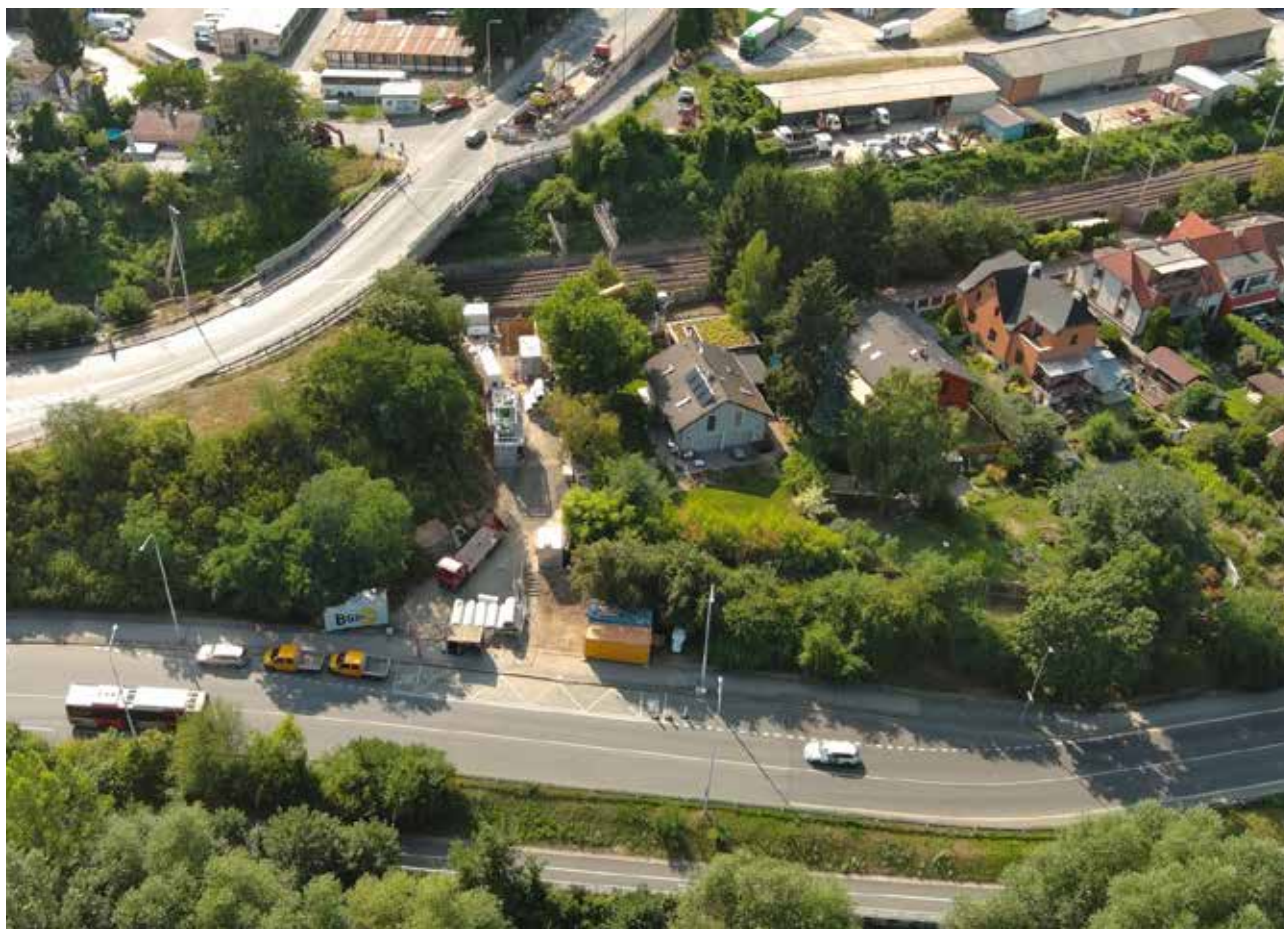
3/ Pohled na stavbu
