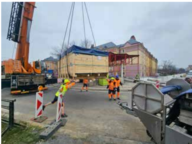
Obr. 2 Manipulace s transportní bednou rukávce. Hmotnost rukávce včetně obalu byla přibližně 14 t; k osazení byl použit mobilní jeřáb o nosnosti cca 60 t. Foto: archiv TRASKO BVT.
