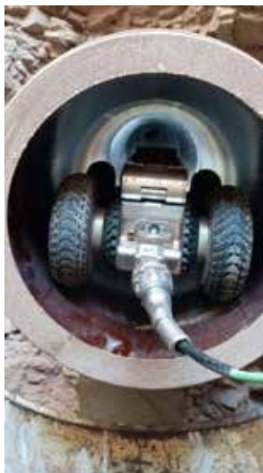
Obr. 8: Kontrola opravené kanalizace na ul. Silurské
