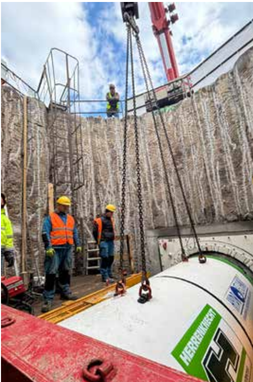
Obr. 3 – Zaražení stroje AVN1200 TC a separační zařízení HKS150
