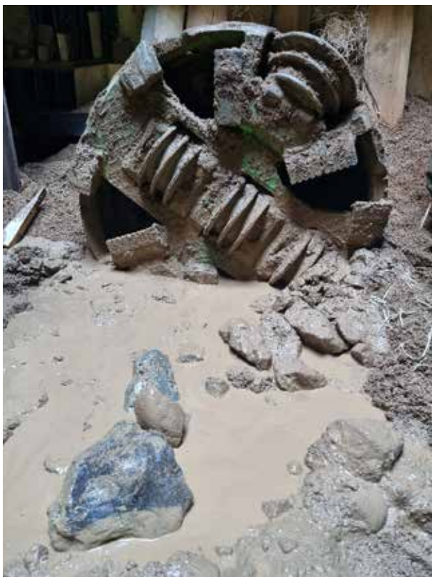
7/ Razicí štít po prorážce do cílové šachty ŠA3
