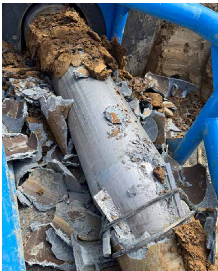
Obrázek 5: Trhací a rozšiřovací hlava (zdroj: fotoarchiv OHLA ŽS, a.s.)
