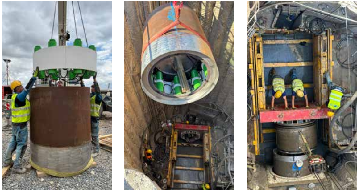
Obr. 7 – Instalace mezitlačné stanice a leading pipe
