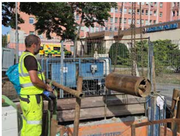
Obr. 4: Ocelová pažnice s vloženým šnekem pro transport vytěženého materiálu
