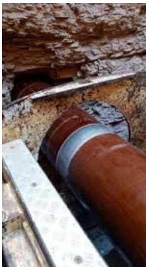
Obr. 7: Glazovaná kameninová protláčecí trouba DN300 mm na ul. Silurská
