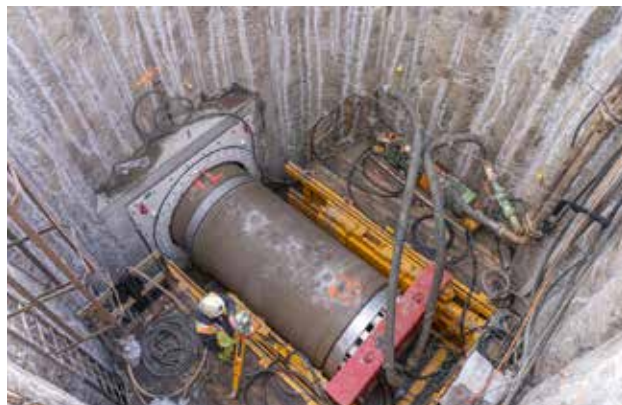
Obr. 2 Mikrotuneláž protlačovacích trub POLYCRETE o profilu DN 1400
