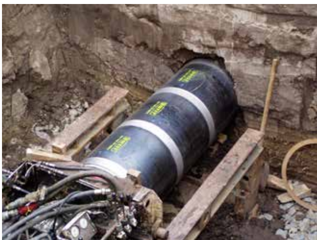
FOTOGRAFIE 9 – Současná fotografie bezvýkopové realizace nebo kanalizační stoky
