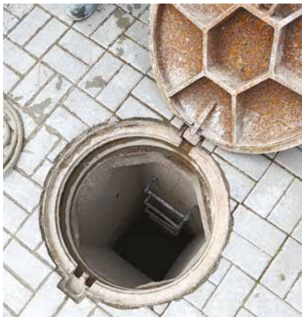
Obr. 5 Přístup DN 600 do stoky
