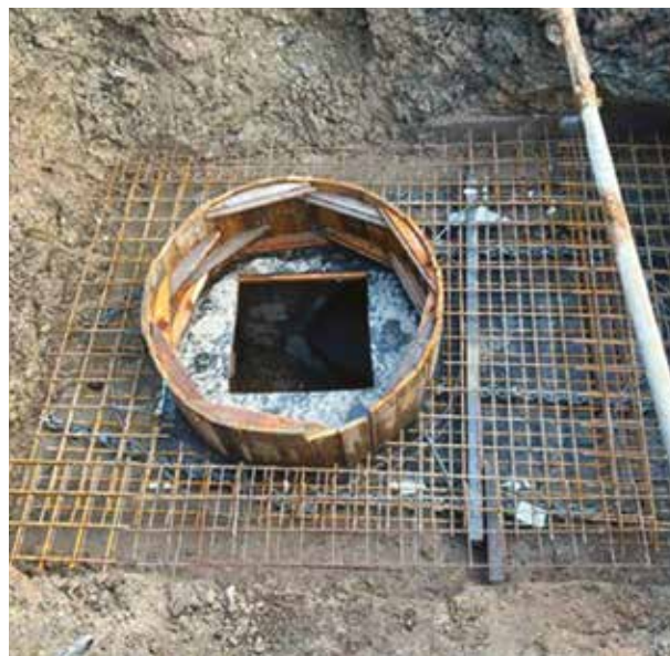
Obr. 9 Zbudování nových zákrytových desek
