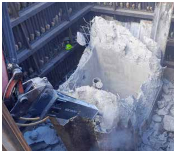
Obr. 9 Bourání původní hradidlové komory (Zdroj: Fotoarchiv OHLA ŽS, a.s.)
