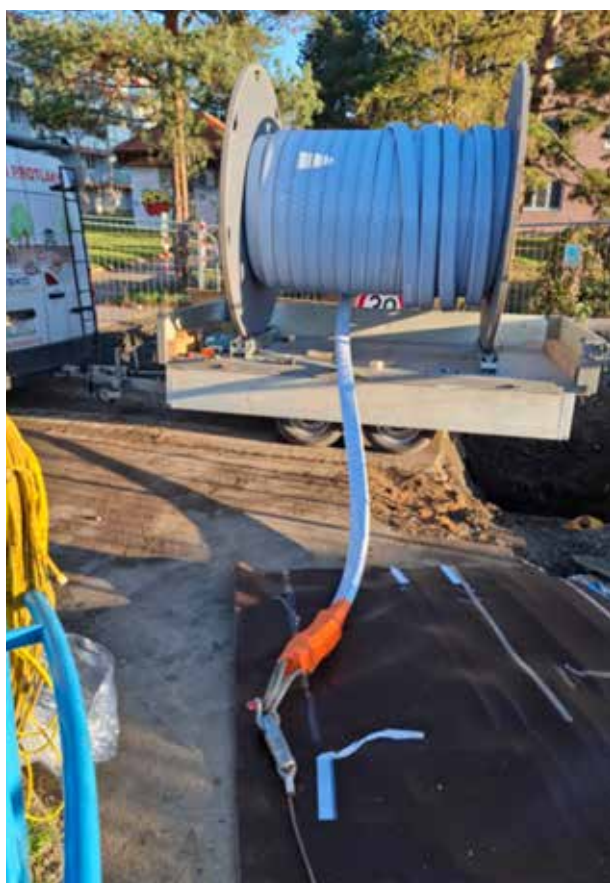
Obr. 5 Instalace vložky Primus Line – přes výkop (mimo mostní konstrukci)
