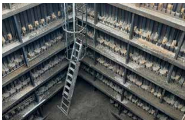
Obr. 2 Zásyp šachty ŠD4 (Zdroj: Fotoarchiv OHLA ŽS, a.s.)
