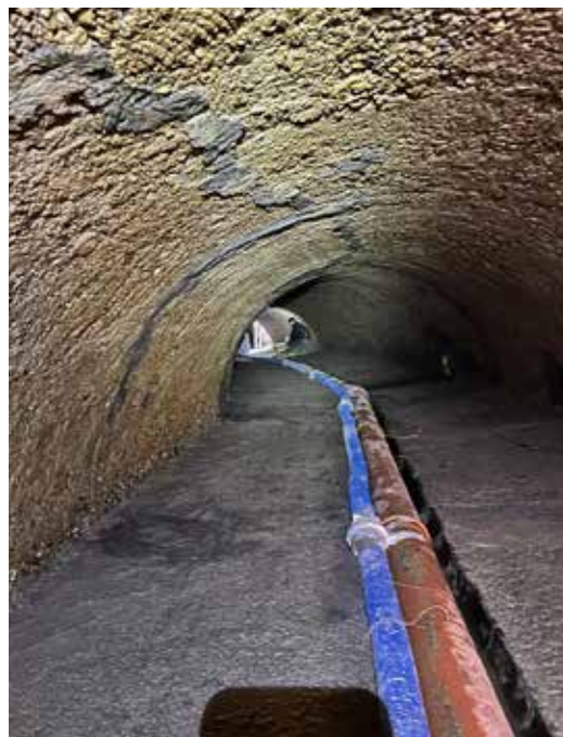
Obr. 6 a 7 Přečerpávání splaškových vod po dobu oprav
