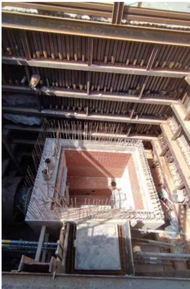
Obr. 10 Hradidlová komora před betonáží stropu (Zdroj: Fotoarchiv OHLA ŽS, a.s.)
