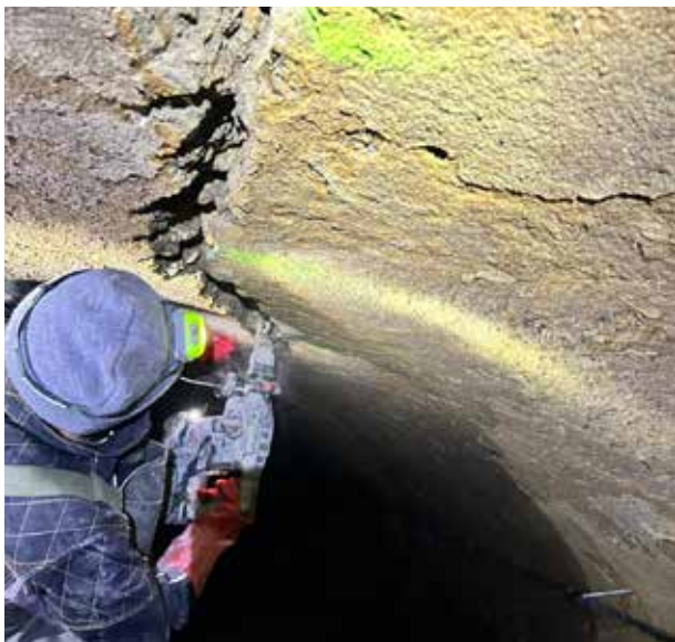
Obr. 8 Otevření spáry pro následnou injektáž
