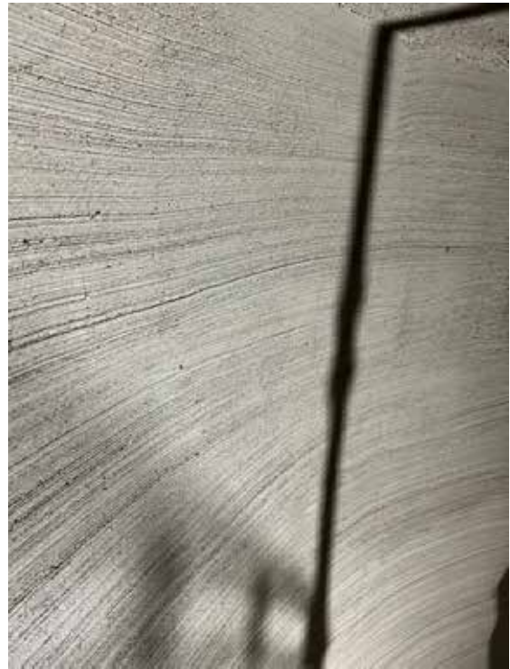
Obr. 16 Reprofilační a zatěšňovací nástřik
