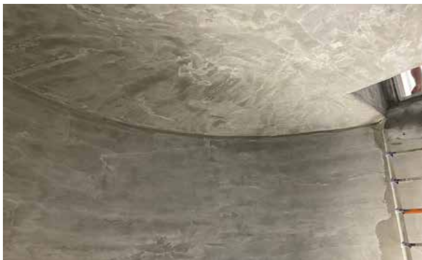
Obr. 17 Aplikace finální uzavírací stěrky
