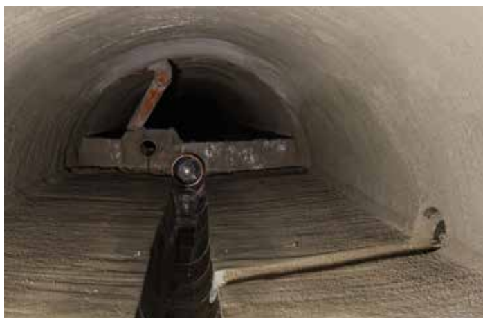
Obr. 6 a 7 Přečerpávání splaškových vod po dobu oprav
