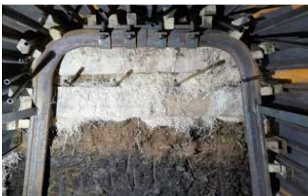
Obr. 6 Čelba štoly A před injektáží (Zdroj: Fotoarchiv OHLA ŽS, a.s.)
