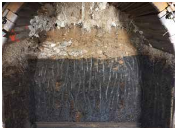
Obr. 4 Foto čelby štoly B po injektáži nadloží (Zdroj: Fotoarchiv OHLA ŽS, a.s.)
