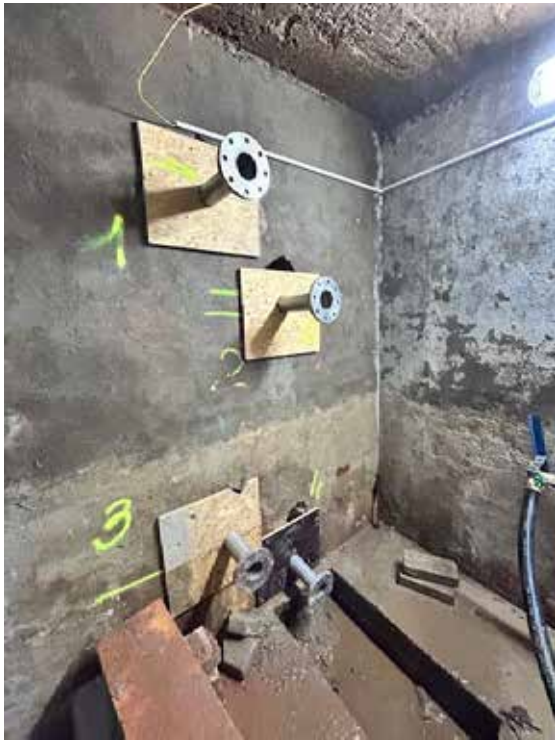
Obr. 15 Instalace prostupů
