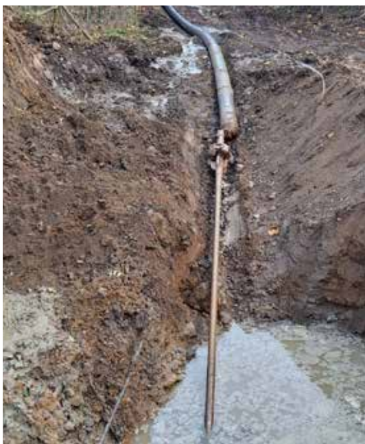
Obr. 7 Příprava vtahování potrubí (Zdroj: fotodokumentace zakázky Vodohospodářská zařízení Šumperk, a.s.)
