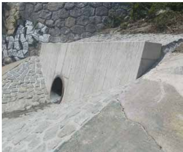
Obr. 11 Vyústění kanalizace DN 1000 do řeky Vltavy
