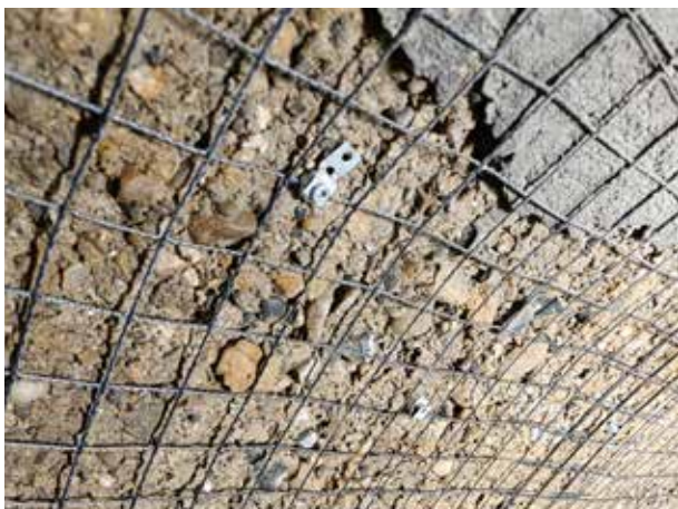
Obr. 9 Instalace síťové kompozitní výztuže
