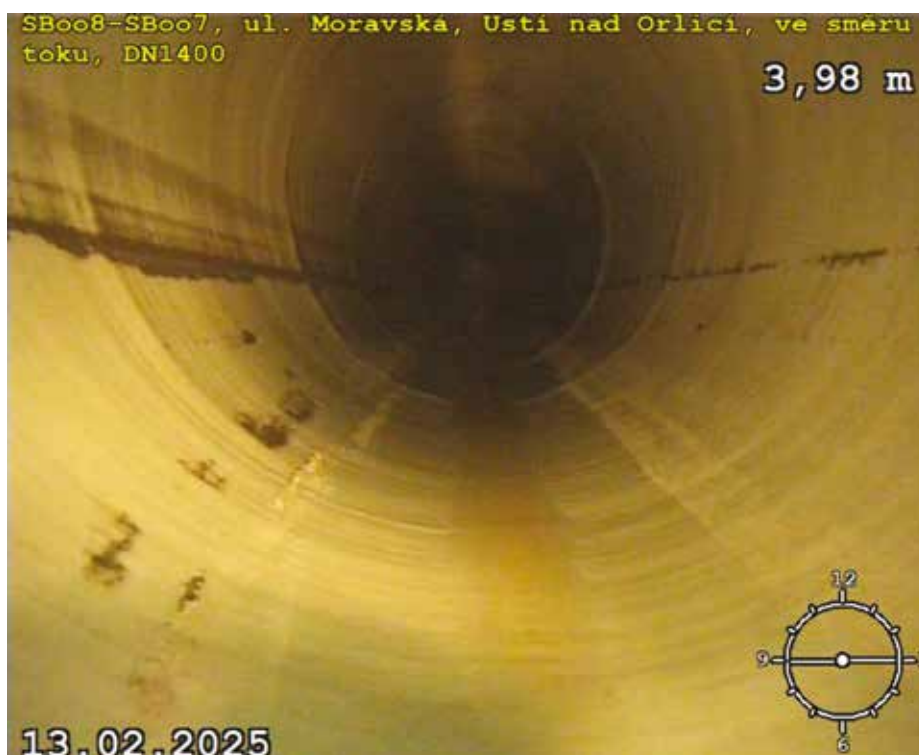
Obr. 10 Stav po opravě
