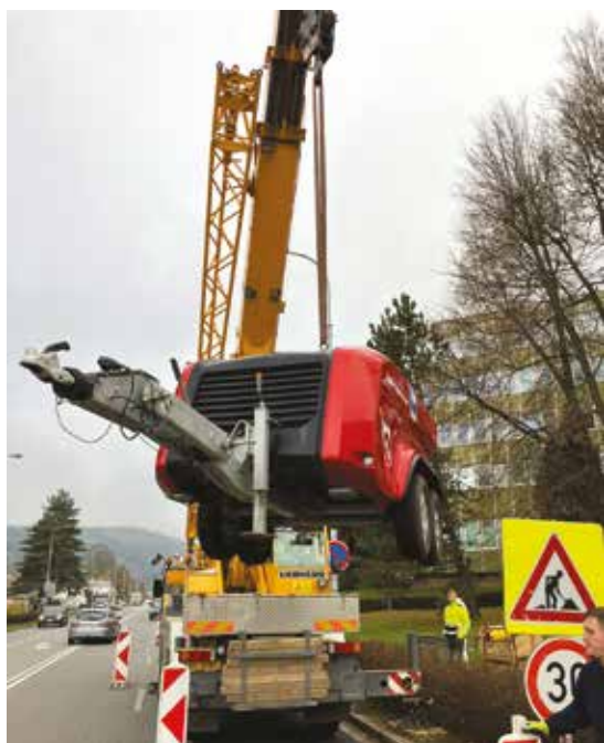
Obr. 6 Umístění navijáku jeřábem
