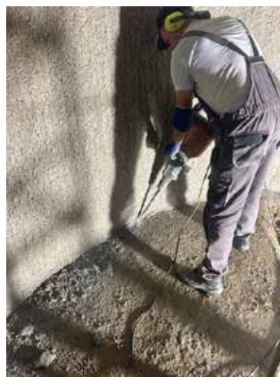
Obr. 14 Vybourání pracovní spáry
