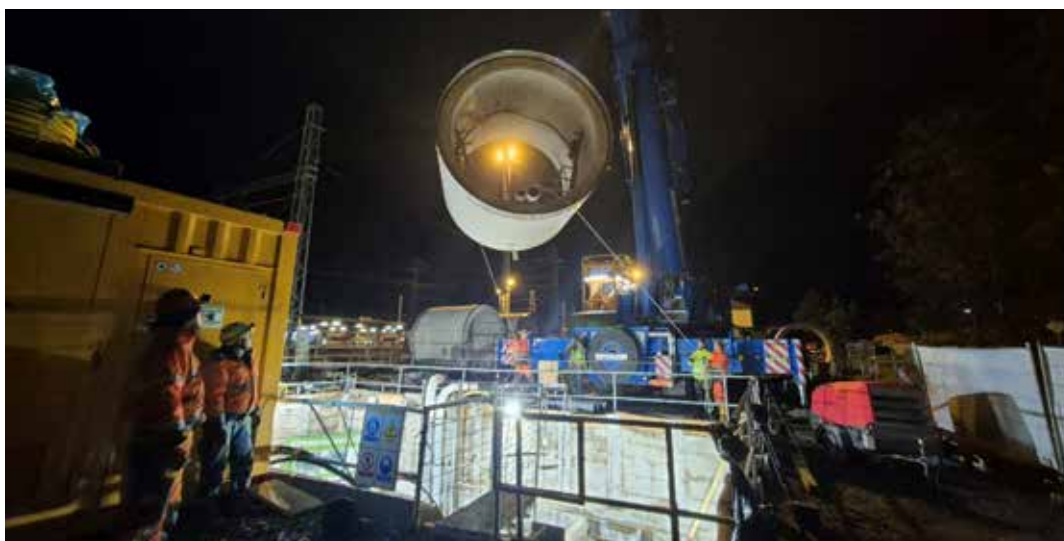
Obr. 7 Osazování dílce protlačovacího potrubí
