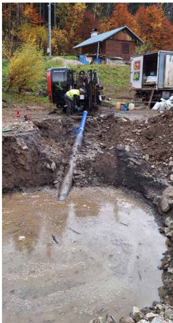
Obr. 14 Ukončení prací – protažení potrubí vodovodu chráničkou (Zdroj: fotodokumentace zakázky Vodohospodářská zařízení Šumperk, a.s.)
