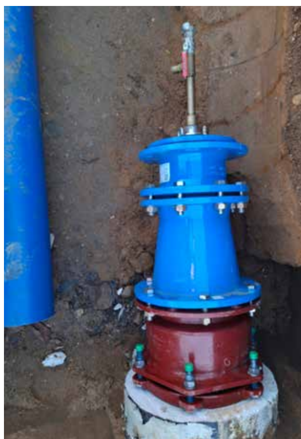
Obr. 6 Instalace konektoru Primus Line
