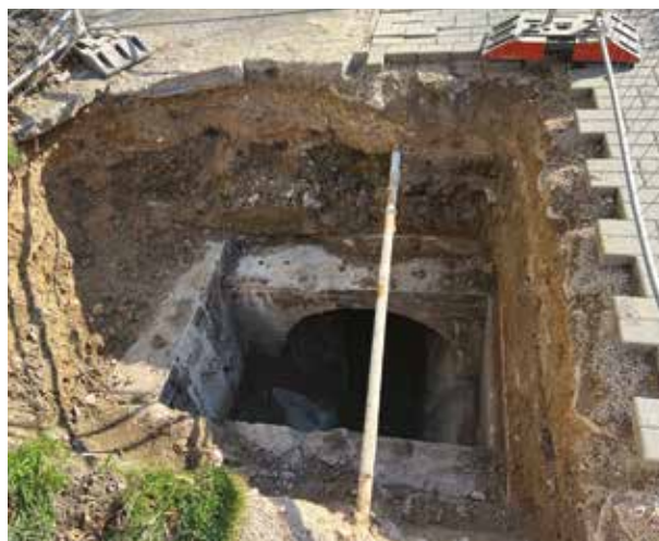
Obr. 5 Příprava kanalizačních šachet
