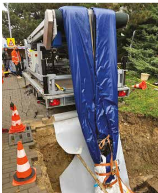
Obr. 7 Zatahování rukávce pomocí dopravníkového pásu
