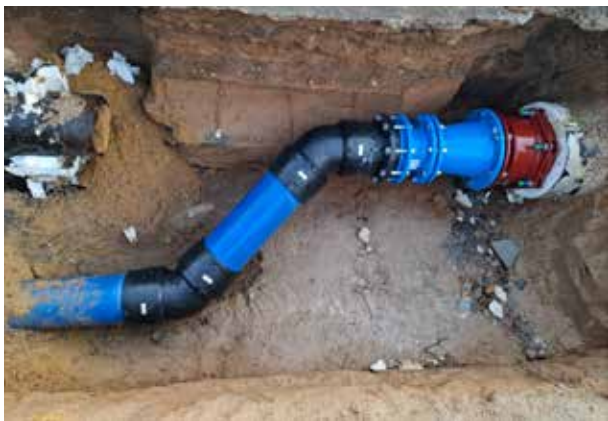
Obr. 7 Propojení sanovaného úseku s vodovodem
