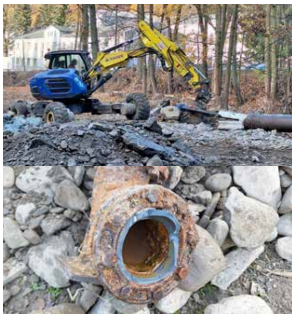
Obr. 8 a 9 Stav opravovaného potrubí uloženého na lávce nad vodním tokem (Zdroj: fotodokumentace zakázky Vodohospodářská zařízení Šumperk, a.s.)
