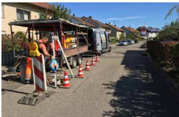
Obr. 7 Instalace DN 300 metodou TIP v Nürtingenu u Stuttgartu od šachty k šachtě
