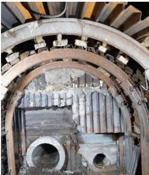
Obr. 5 Konec ražby v šachtě ŠD4 (Zdroj: Fotoarchiv OHLA ŽS, a.s.)
