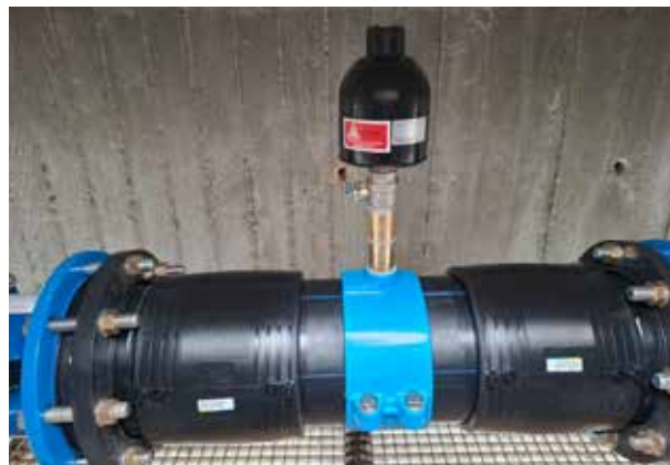
Obr. 8 Osazení vzdušníku ve středovém poli – nejvyšší bod klenuté mostovky
