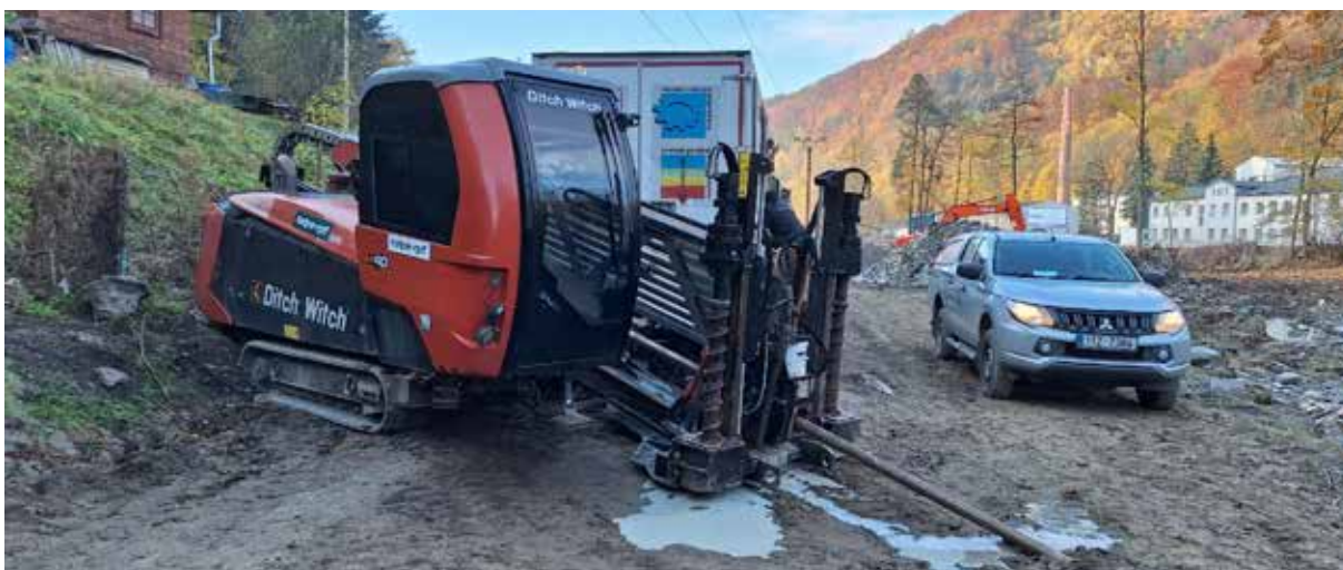
Obr. 6 Vrtná souprava DitchWitch AT40 pro vrtání ve skále (Zdroj: fotodokumentace zakázky Vodohospodářská zařízení Šumperk, a.s.)
