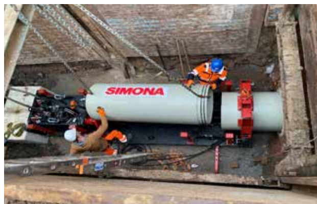
Obr. 8 Instalace DN 1000 metodou TIP v Erfurtu
