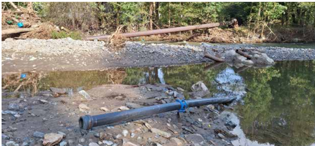
Obr. 1 Řeka Morava – stav po povodni (Zdroj: fotodokumentace zakázky Vodohospodářská zařízení Šumperk, a.s.)
