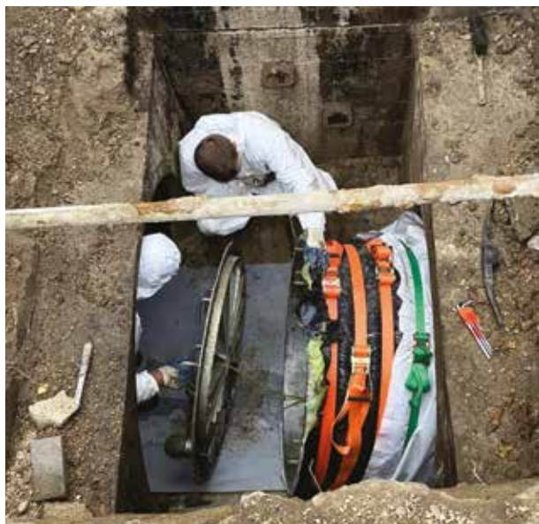
Obr. 8 Uzavření rukávce pro tlakování
