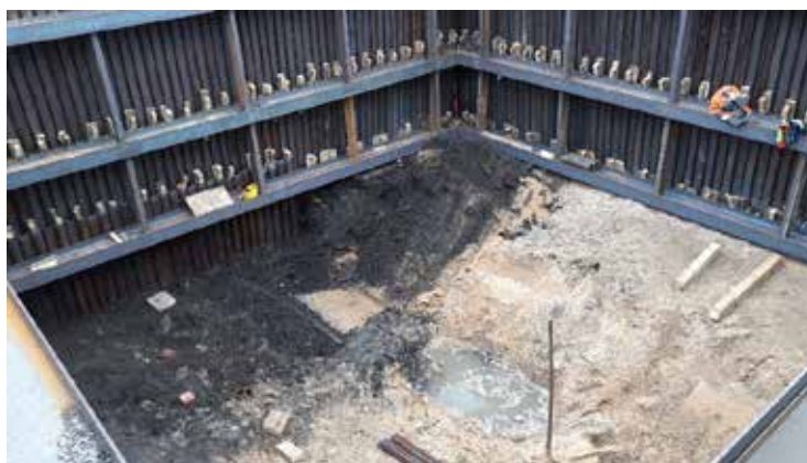
Obr. 4: Výkop šachty Š107, při naražení na podzemní vodu
