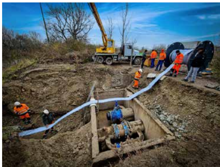
Obr. 3 – sanace shybky DN 600 pod Váhem v Trenčíně
