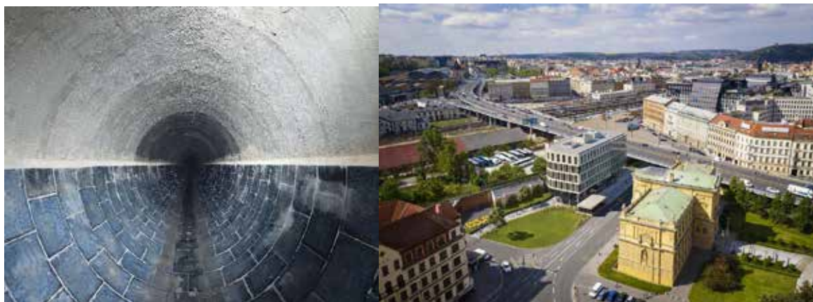
Dokončení stoky a pohled na hotový Florenc Gate
