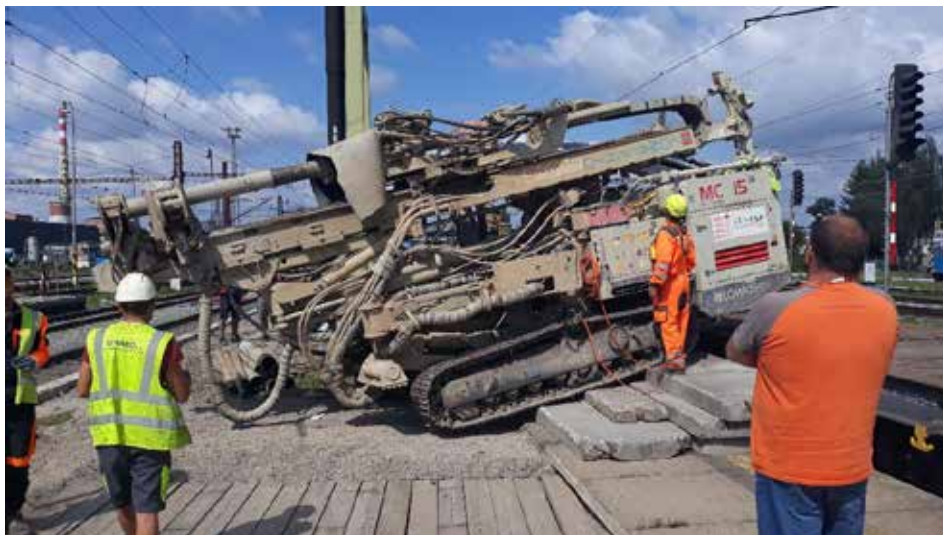
Obr. 5: Příprava vrtu pro hlubinný průzkum na nástupišti č. 2
