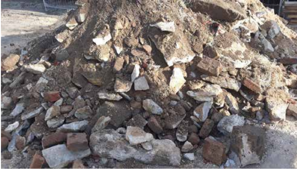
Obr. 8: Materiál vytěžený z protlaku
