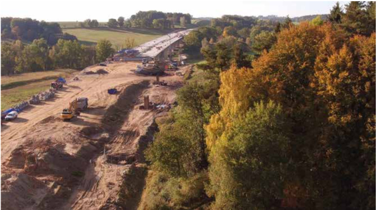
Obrázek 1 – Celkový pohled na stavbu S0301.b – Stoka G1, v pozadí S0 209 Most přes údolí Plavnice
