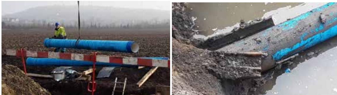
Obr. 5: Zatahování trub do stávajícího rozřezaného a rozšířeného potrubí
