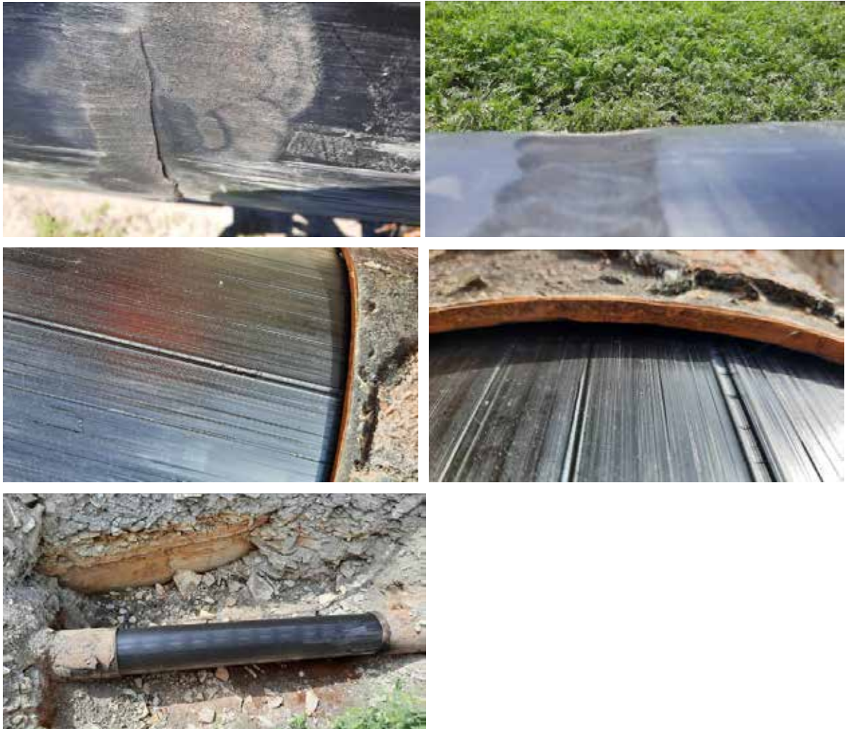
Obr. 2: Vnitřní vyčištěná plocha stěny ocelového potrubí, přesahy s ostrou hranou v místě svařovaných spojů cca 5 mm
