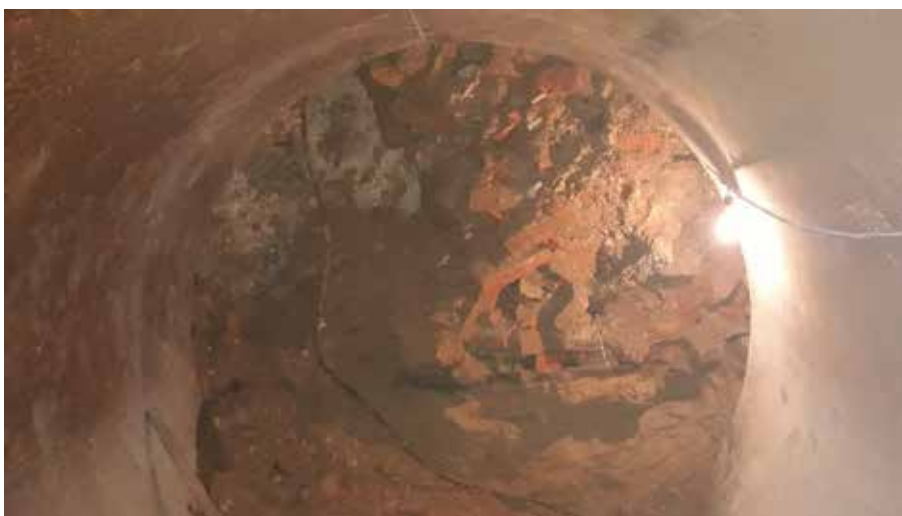
Obr. 7: Pohled na čelbu protlaku DN 2000 mezi Š35 a Š36
