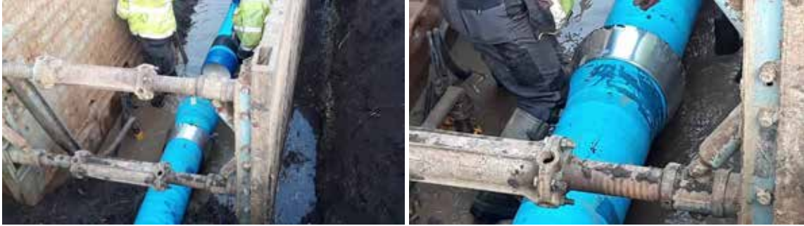
Obr. 5: Zatahování trub do stávajícího rozřezaného a rozšířeného potrubí
