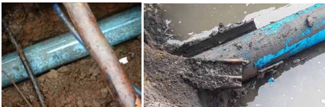
Obr. 3: Pro bertlining nabízí potrubí z tvárné litiny vysoce mechanicky odolnou ochranu žárového zinkování vrstvou cementovou vyztuženou maltou
