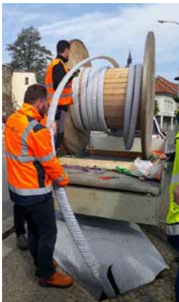
Obr. 5 a 6 – Instalace vložky přes stávající armaturní komoru – 100 % No DIG
