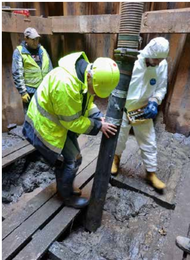
Obrázek 8 – Vysátí bahnin sacím bagrem ze dna Š66
