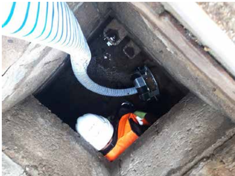
Obr. 5 a 6 – Instalace vložky přes stávající armaturní komoru – 100 % No DIG
