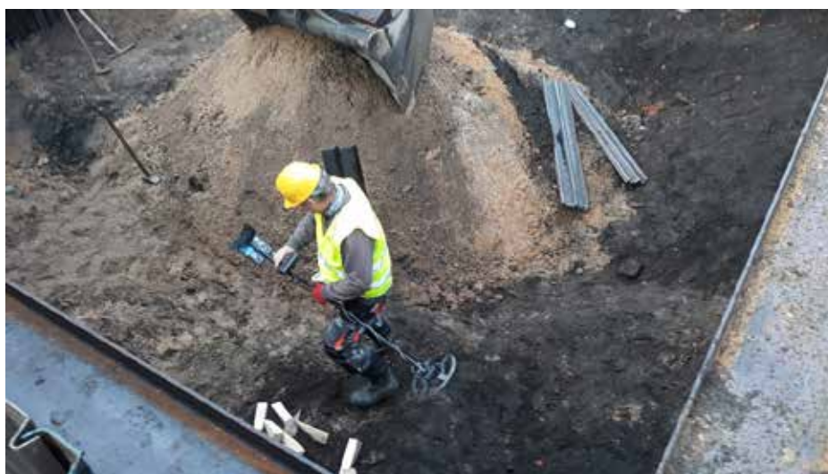
Obr. 3: Kontrola pyrotechnikem před dalším postupem prací
