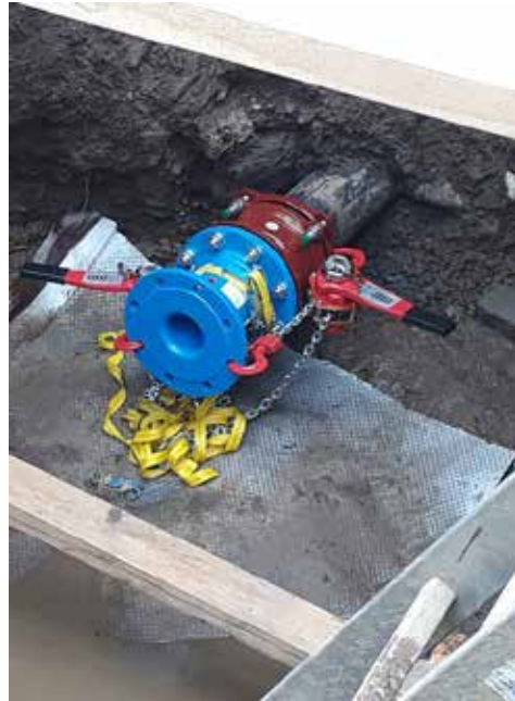
Obr. 7 a 8 – situace na levém břehu řeky Oslavy při vtahování; přírubový konektor po montáži
