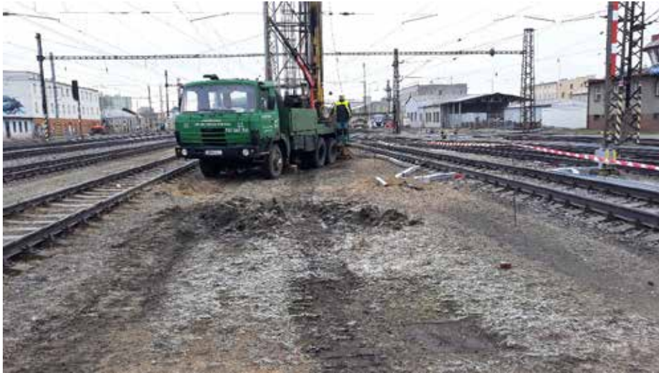
Obr. 6: Vrtná souprava mezi kolejemi při realizaci hydrovrtů
